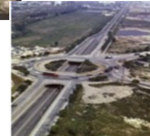
Médiathèque Terra MTES
